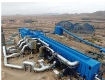
● گندله سازی تایباد ● کارفرما: سازه های صنعتی آذران ● محل پروژه: خراسان - تایباد
