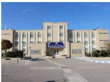
● خوابگاه دانشگاه علوم پزشکی گناباد ● کارفرما: شرکت صنعتی آموت سپهر ● محل پروژه: گناباد
