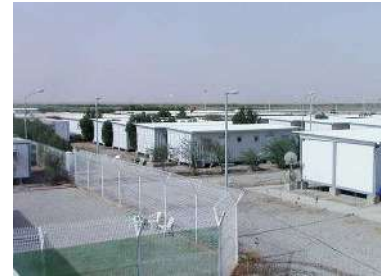
● پروژه نفتی یادآوران اهواز ● کارفرما: شرکت پادکاو انرژی ● محل پروژه: خوزستان- اهواز
