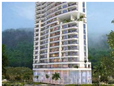
● برج رویا رزیدنس ● محل پروژه: نمک‌آبرود
