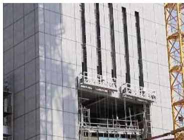
● اتاق بازرگانی ● کارفرما: شرکت کیسون ● محل پروژه: تهران
