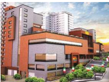
● پروژه: آریان پاسارگاد ● کارفرما: شرکت اروم سازه ● محل پروژه: تهران
