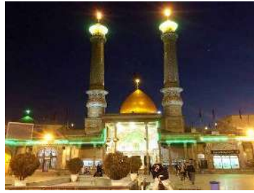
● ساختمان آستان حضرت عبدالعظیم ● کار فرما: اداره کل فنی و عمران آستان ● محل پروژه: شهر ری
