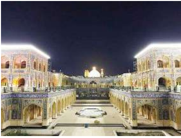
● صحن حضرت زهرا (س) ● کار فرما: شرکت مطسا ● محل پروژه: عراق – نجف
