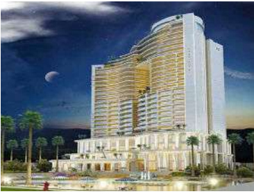
● هتل آراز ● محل پروژه: نوشهر
