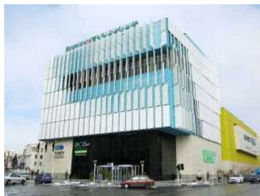
● اکومال ● کارفرما: شرکت صنا اوج ● محل پروژه: مشکین دشت
