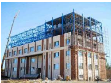
● کارگاه ساختمان اداری آبفا ● کارفرما: شرکت ساختمانی تدبیر عمران ● محل پروژه: زنجان
