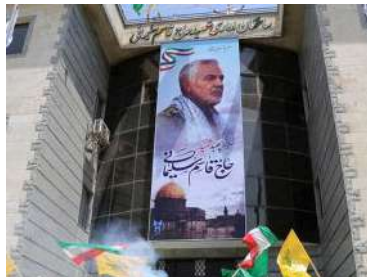
● ساختمان اداری شهید حاج قاسم سلیمانی ● کارفرما: شرکت مهندسی پاراوان ● محل پروژه: تهران
