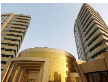
● برج های طلایی کیش ● کارفرما: شرکت پارس کالا کیش ● محل پروژه: هرمزگان - کیش
